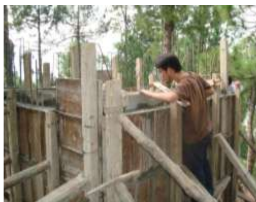
建設中の貯水タンク
