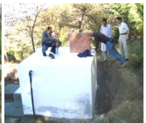
完成した貯水タンクの検査
