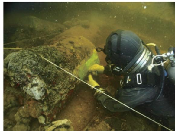
亀裂からのピクリン酸漏洩防止のため水中硬化型防食材による亀裂補修
