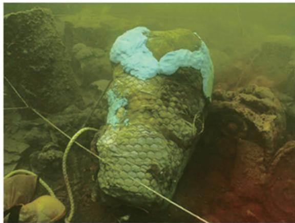
更に腐食が進んでいる爆雷は、ビニール・金網を利用して完全密封処置
