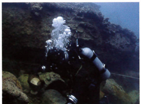
爆雷補修作業を行う牧専門家
