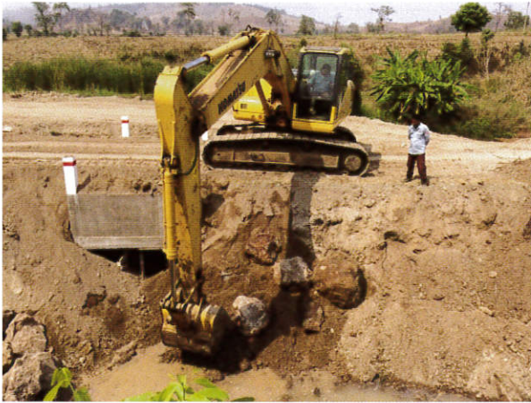
道路造成に不可欠なカルバート構築現場の様子 雨季の大水に備え壊れない為、基礎部分をしっかり構築する大事な工程
