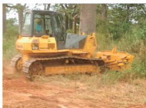
JMAS通りの道路整備
