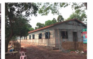
屋根工事中の学生宿舎
