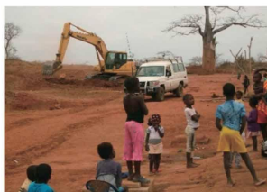
ゴミ処分穴の掘開
