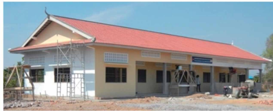
完成間近なルン村小学校 After
