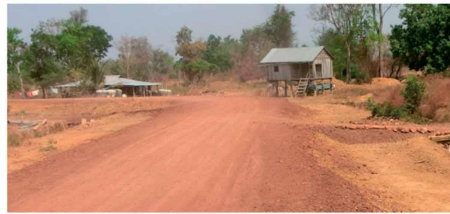
チサン村の既整備道補修後の状況
