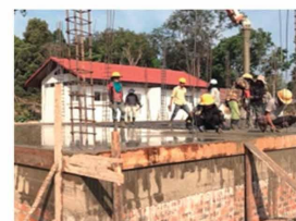
床工事中の学生宿舎
