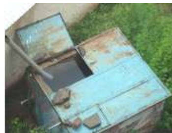
雨水を貯めるタンク
