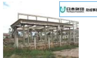
建設中の教場
