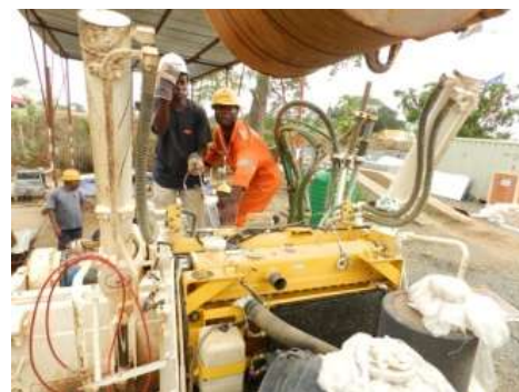
除去機の改修作業中のスタッフ
