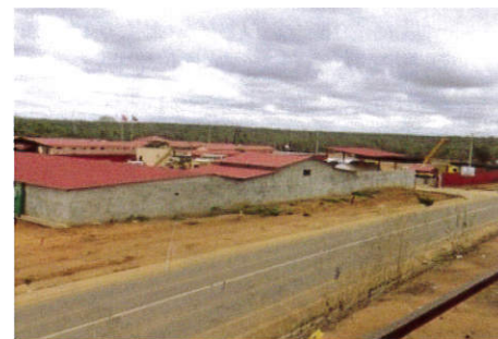
地雷除去地に浄水場を建設中
