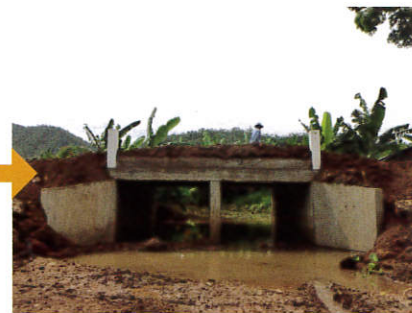
After: 左の写真と同じ場所に建設中の水路橋
