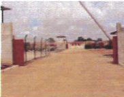
5万人用給水施設を建設中
