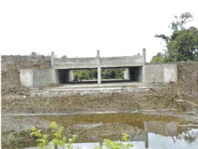
特注品の大型ボックスカルバート
