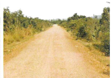
ラテライト敷設後の補修道路
