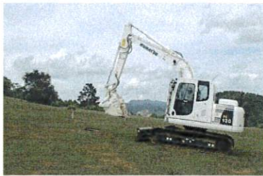
作業中の処理機
