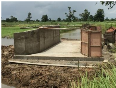
建設中の暗渠
