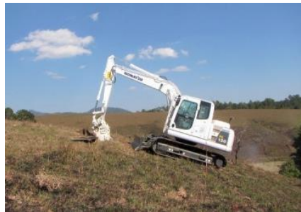
傾斜地で処理作業中の処理機
