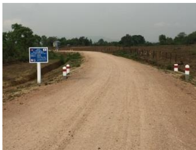
新設道路の構築
