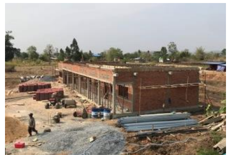
立替中の小学校新校舎
