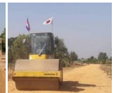
道路建設補修
