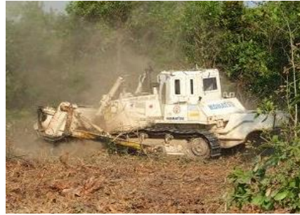
地雷除去機よる処理
