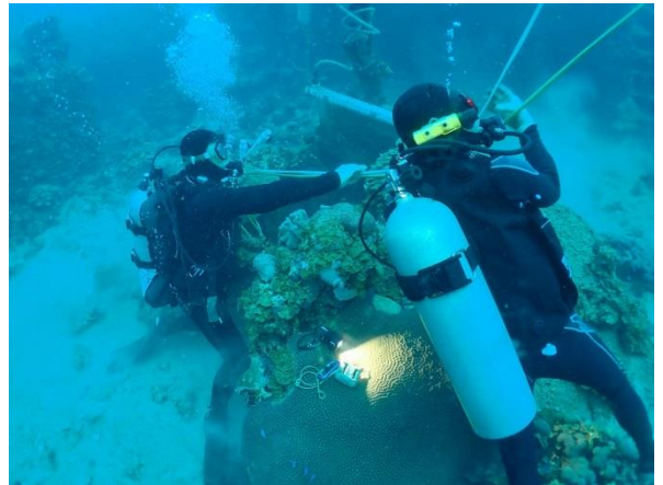
油回収用ホースを戦没船に設置する専門家
