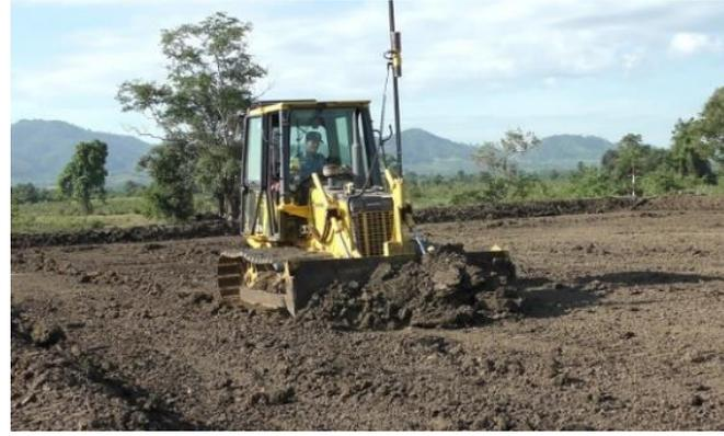
レーザー測定技術を用いた均平作業
