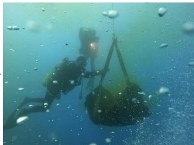
船倉から作業場へは、バルーンを使って爆雷を移動します
