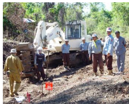
地雷の機械処理現場確認
