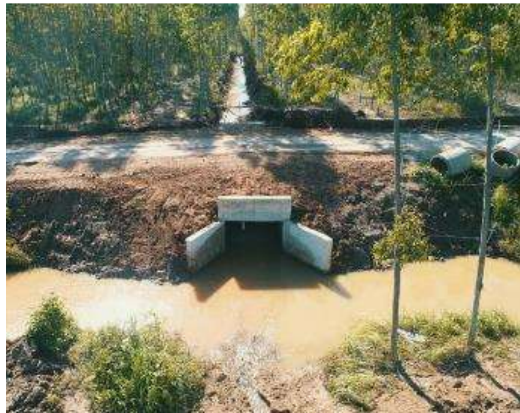
整備された排水設備
