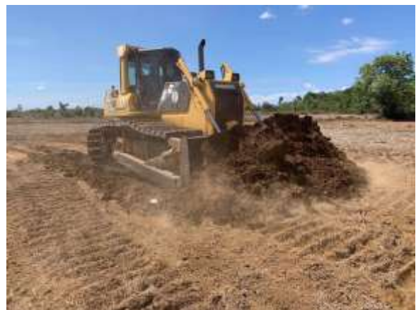
中型ドーザーで土砂の運搬
