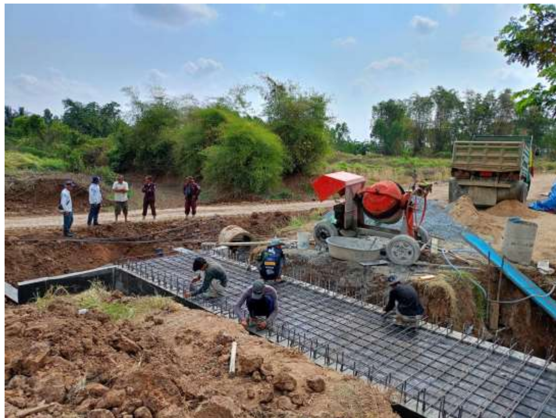
現地の人々の手で排水設備を 工事することで技術が身につく
