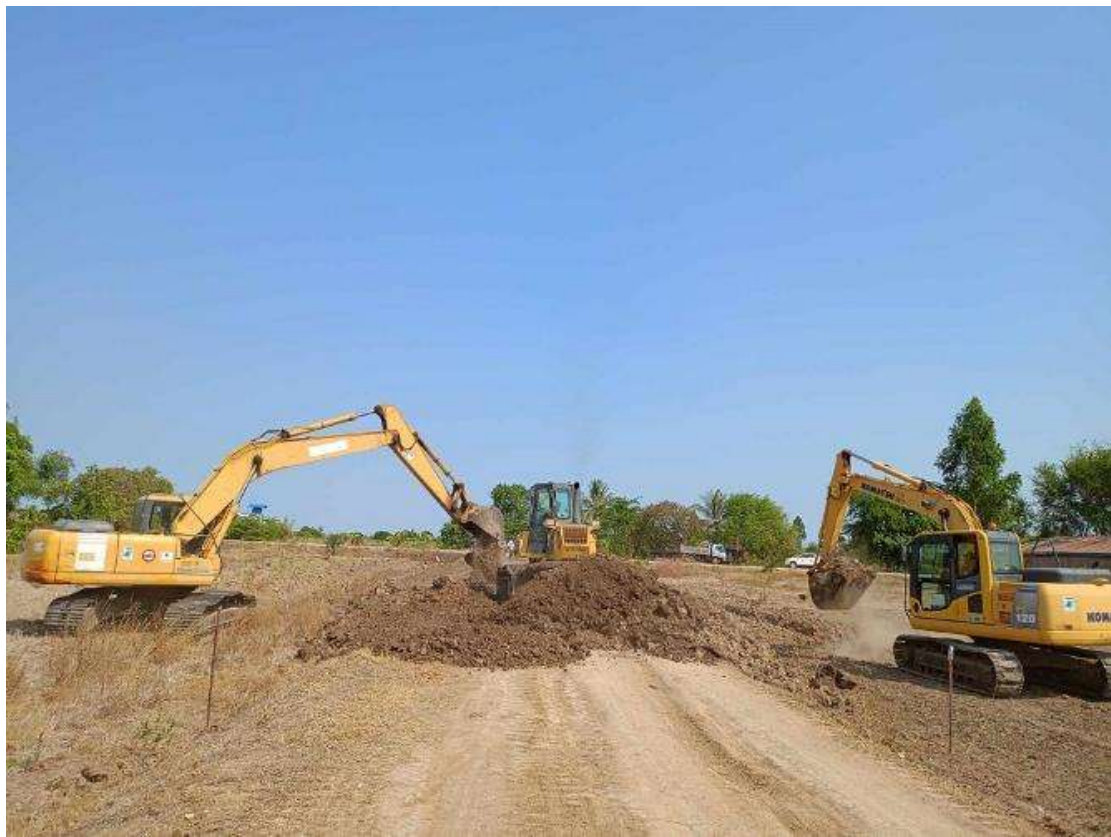
油圧ショベルや中型ドーザーで整地
