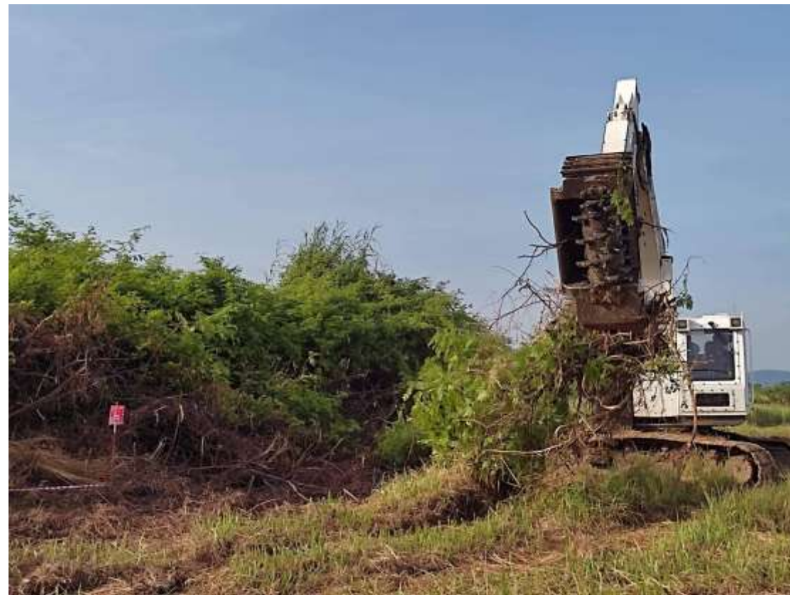
樹木材除去機（日立）による除去
