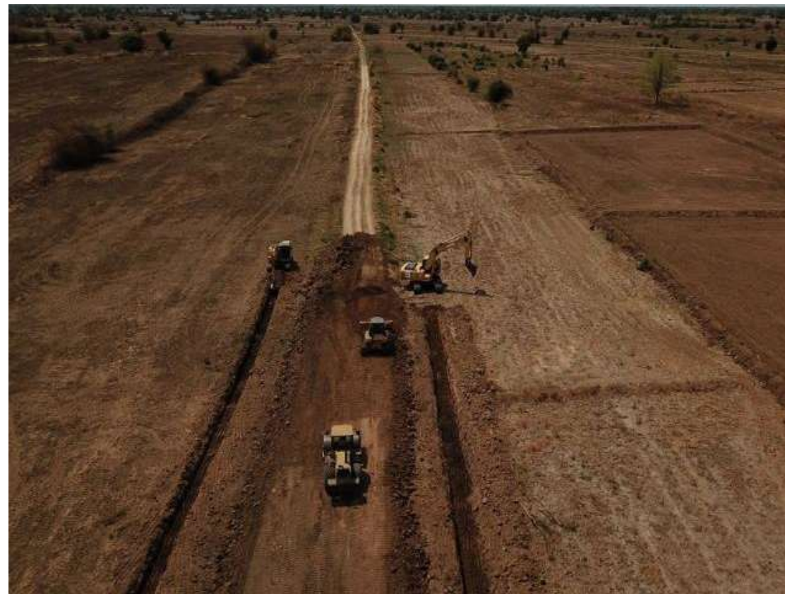
道路や側溝の整備状況をドローンで確認
