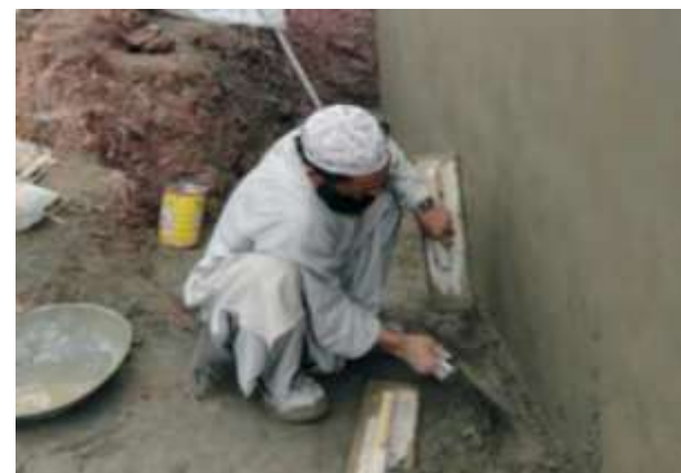
水道施設の整備 (パキスタン)
