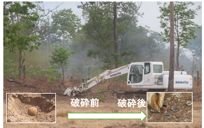
クラスター弾除去機による破碎処理
