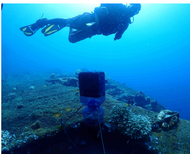
回収器を設置し油流出を防ぐダイバー
