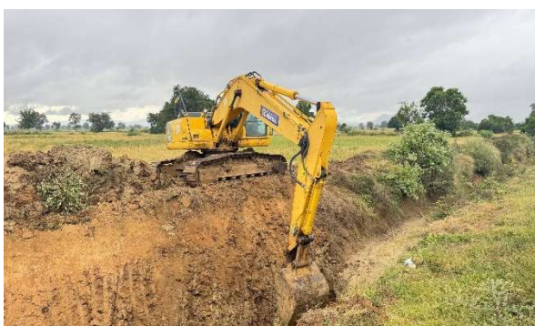
用水路の整備
