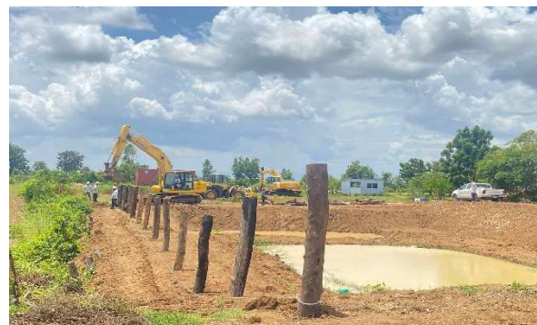
溜め池に外柵を設置
